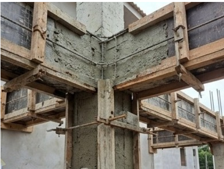
Frente de serviço principal
