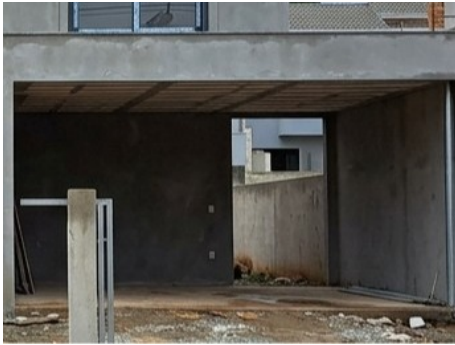
Etapa concluída no dia
