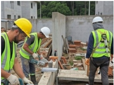
Serviço executado no dia - detalhe
