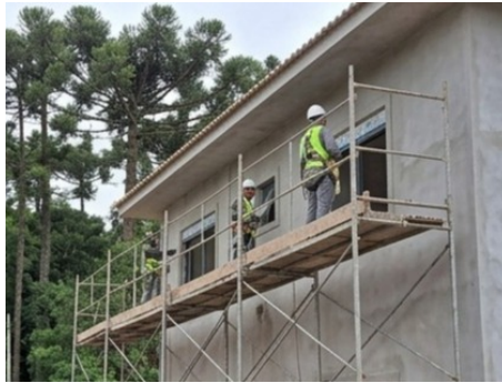
Vista panorâmica da obra
