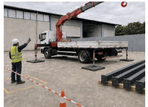
Foto - Equipamento posicionado para o serviço
