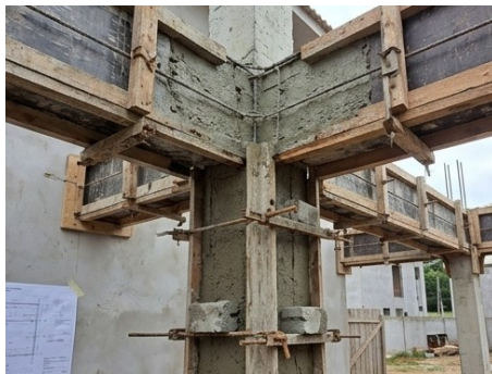
Foto de detalhe de pilares ou vigas
