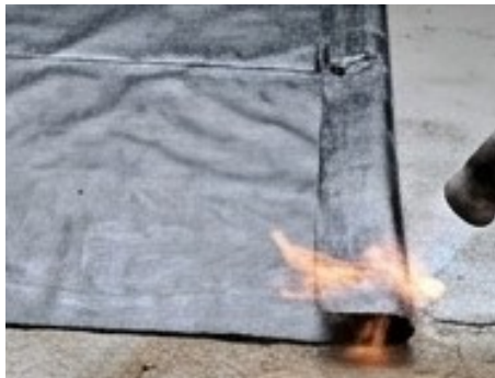
Foto da impermeabilização de laje ou área molhada
