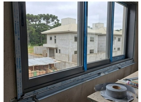
Foto de caixilhos e vedações
