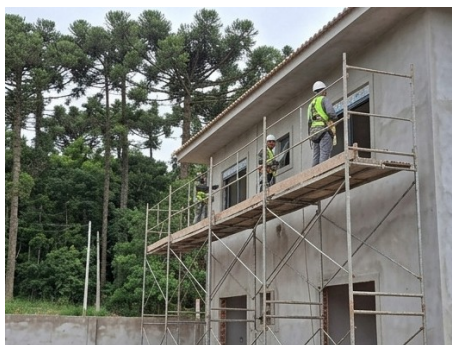
Foto de andaimes ou estruturas de acesso em altura
