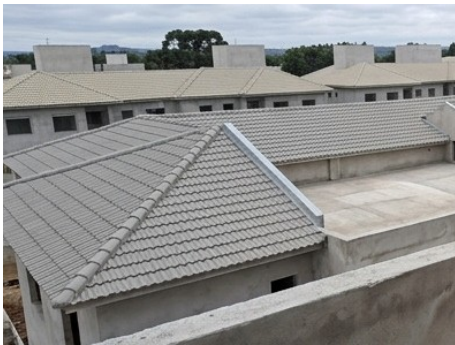
Foto geral da cobertura e do telhado
