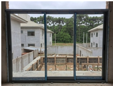
Foto de detalhe de juntas e acabamento
