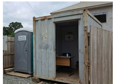
Foto das instalações provisórias
