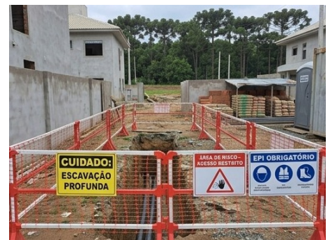
Foto da sinalização e do isolamento de áreas de risco
