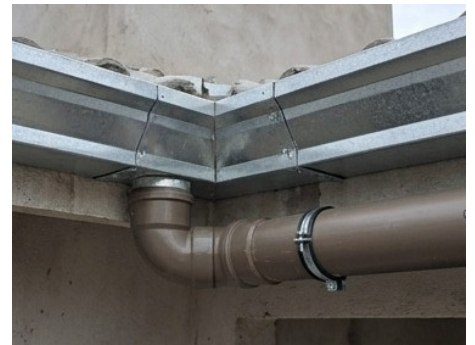
Foto de calhas e condutores de água
